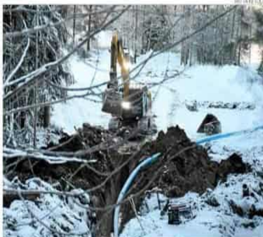
Sipoossa laajennetaan vuosittain vesi- ja viemäriputkia kaava-alueiden ulkopuolelle. Parhailaan Keski-Uudenmaan Vesi uusii Pohjois-Paippisista Järvenpään kulkevaa runkolinjaa, josta sipoolaisillekin tulee vettä.
